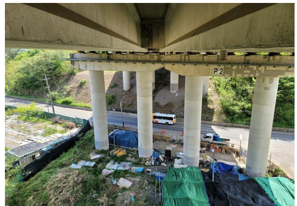
교각 P2 기초 전경
