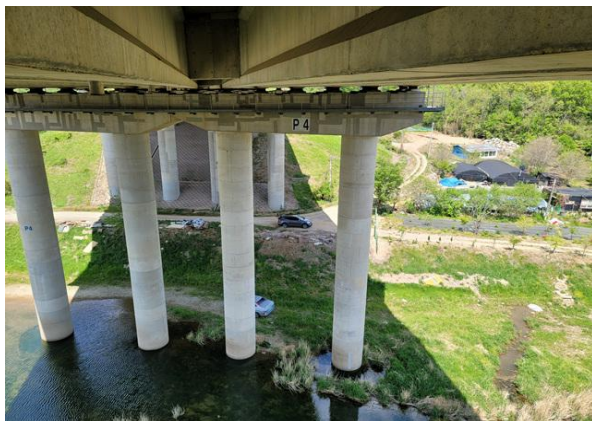
교각 P4 기초 전경
