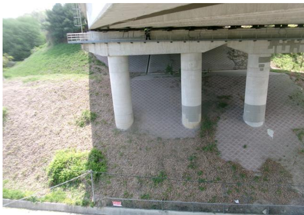
교각 P1 기초 전경
