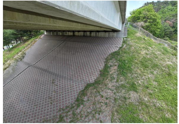
교대 A2 기초 전경
