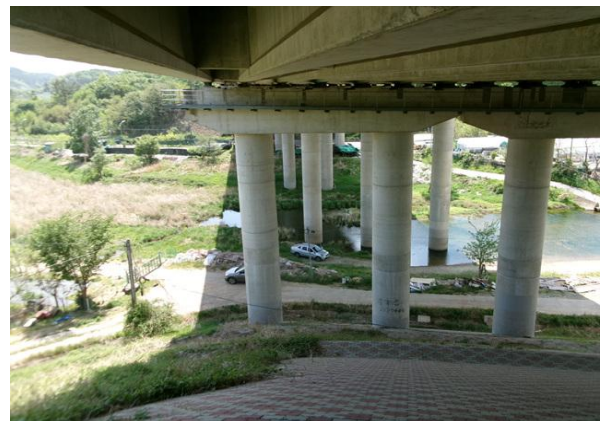
교각 P5 기초 전경
