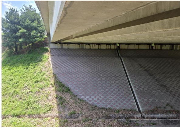
교대 A1 기초 전경
